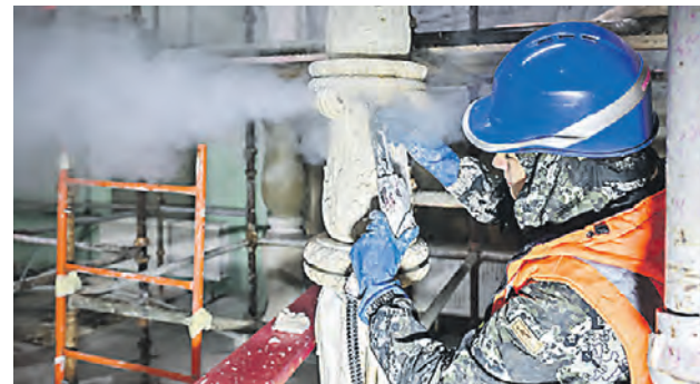
22 октября. Ход комплексной реконструкции Центрального Московского ипподрома на улице Беговой
