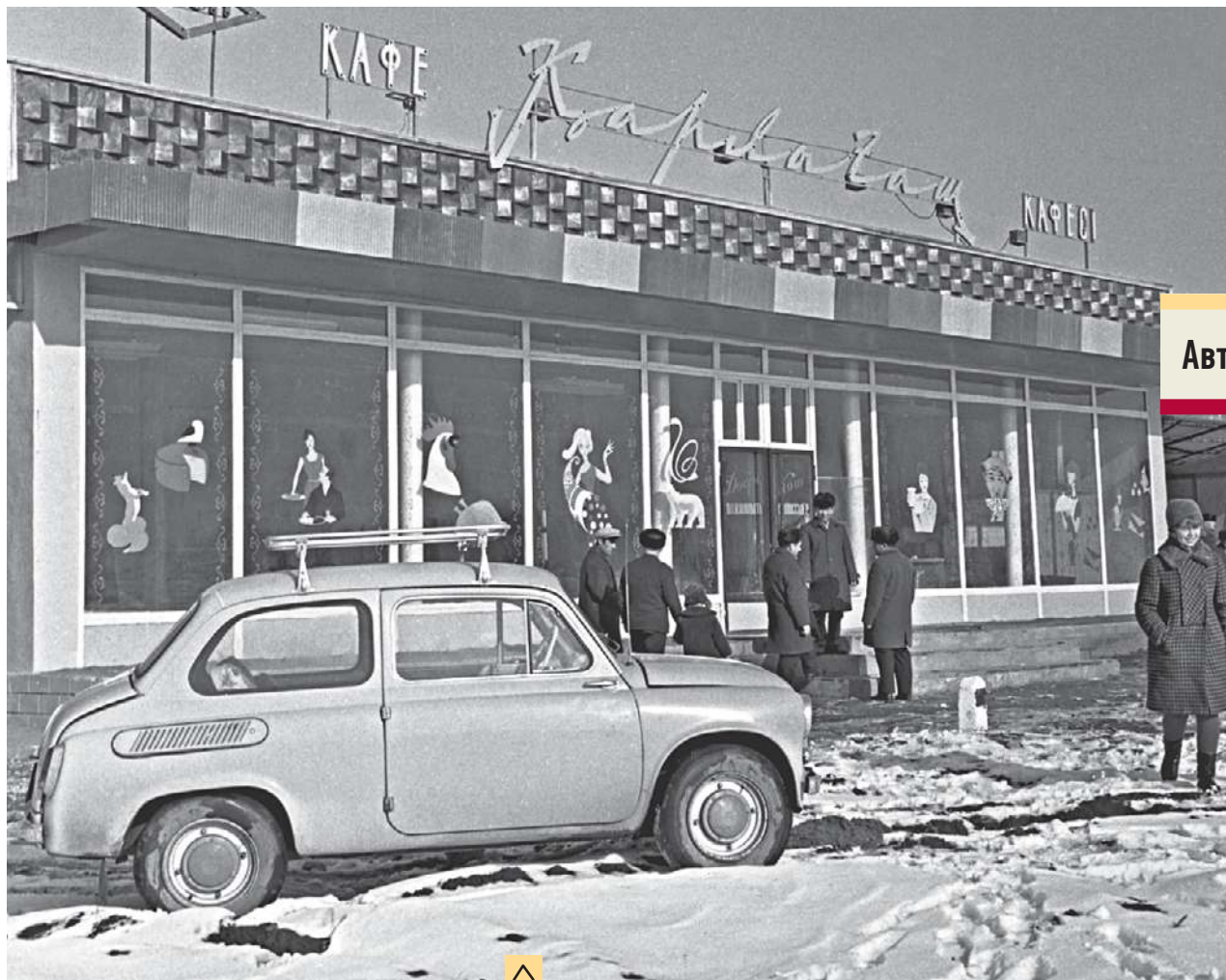
«Запорожец» у кафе «Карлыгаш» в селе Ново-Воскресеновка Жамбылской области Казахстана. Фото 1968 года
