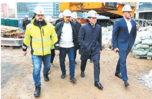
Губернатор проинспектировал ход строительства.
